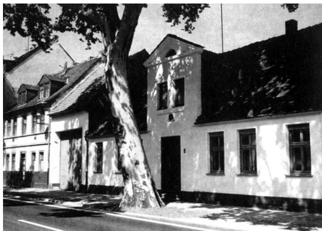
Abb.: Saniertes klassizistisches Wohnhaus in der Mittagstr. 3
