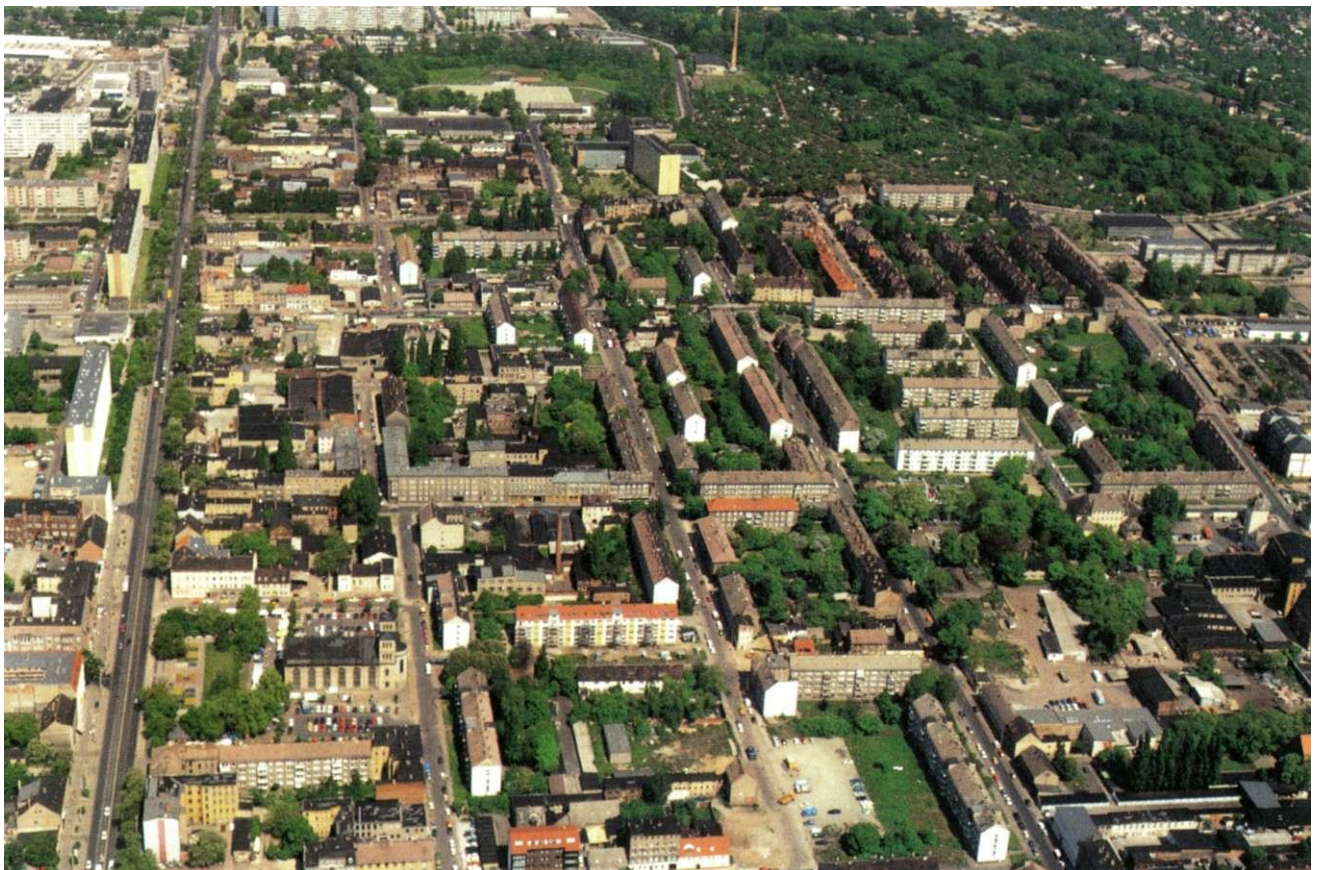
Abb.: Der östliche Teil der Neuen Neustadt im Luftbild (Blick nach Norden)
